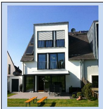
2012 Doppelhaushälfte Fanny-Hensel-Straße 15 Leinfelden-Echterdingen
