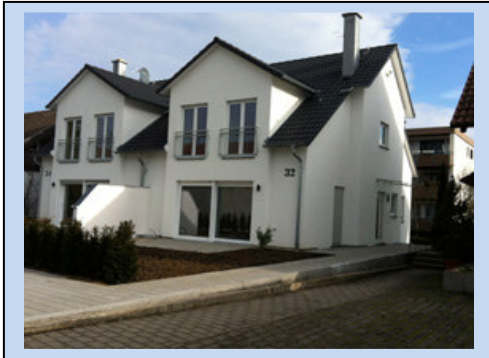
2014 2 Doppelhaushälften Schubertstraße 32 und 34 Wolfschlugen
